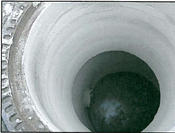
Beschreibung: Probeentnahmeschacht beschichtet
