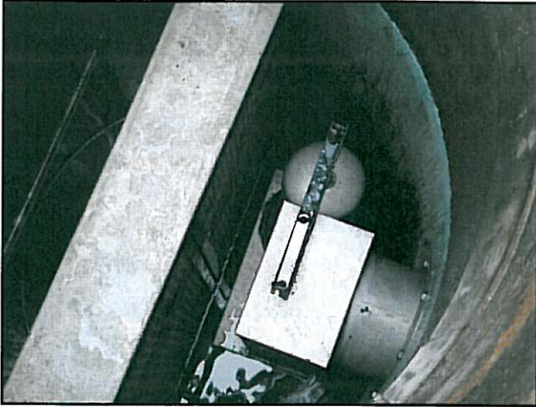
Beschreibung: Koaleszenzabscheider Auslaufverschluß/Schwimmer
